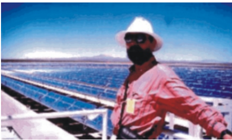
Vista de una Central solar en California, EE.UU
