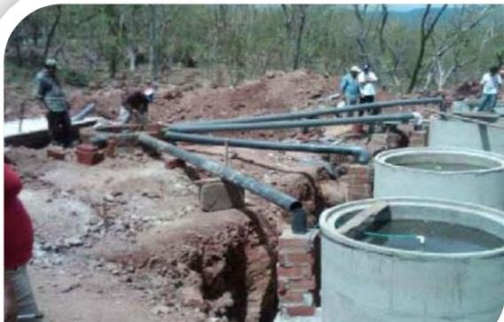
Figura 15: Construcción de la pileta de distribución e alimentación de los digestores, Juigalpa, Nicaragua.
